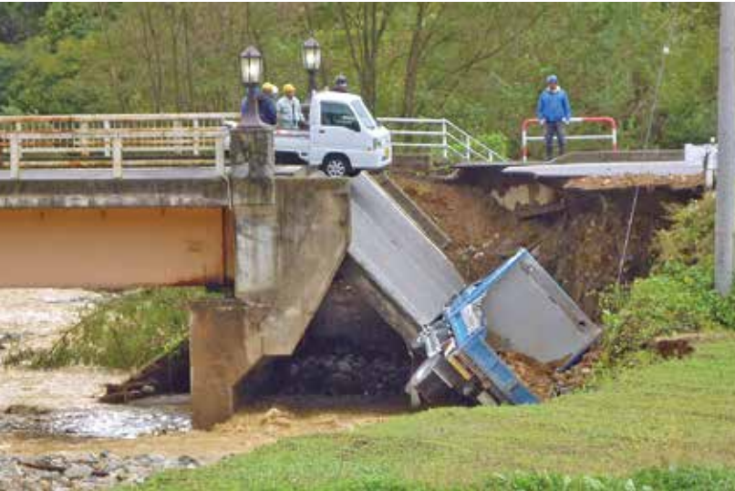
武石新橋 橋台付近の道路が陥没、トラックが転落
