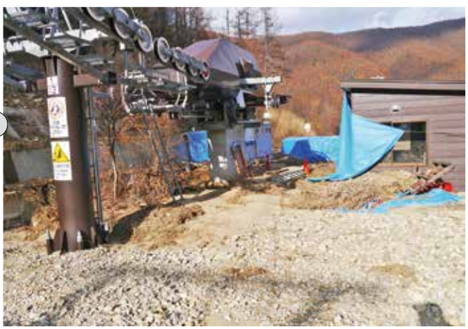
▲台風19号災害で埋まったリフト乗り場と運転小屋
