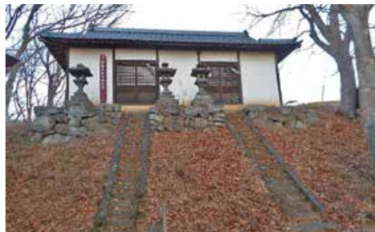
東御市祢津東町の大日堂境内の石尊権現拝殿(左)
