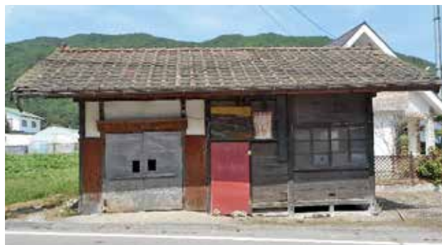
9月7日、解体直前の旧上武石区消防団器具庫・詰所
