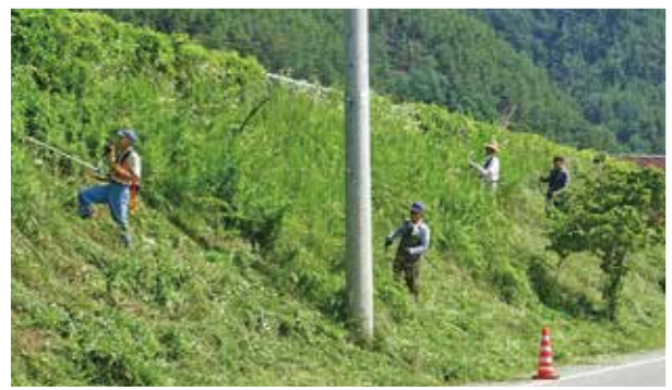
武石新橋付近 県道のり面
